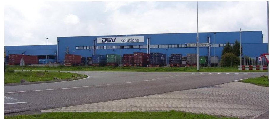
Multi-tenant warehouse van DSV in Moerdijk
